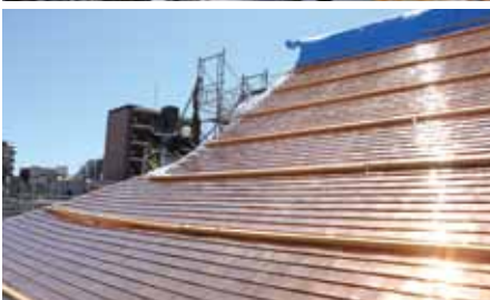
400m 2 を超える大断面の屋根は、職人が手作業で銅板一枚、一枚を葺いていった。
