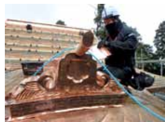
急ピッチで進む屋根工事
