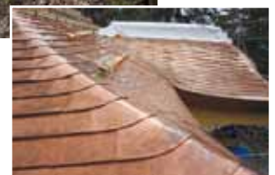
難しいとされる屋根の曲面も忠実に再現されている
