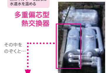
6本の銅管をスパイラルに加工、さらに芯をずらして組み合わせ、輪の隙間を埋めている
