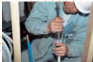
5 サイジングツールで管端を真円に修正
