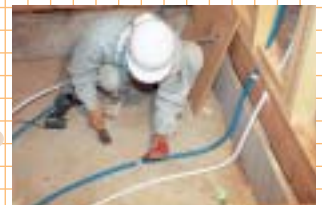
7 銅管を床に固定
