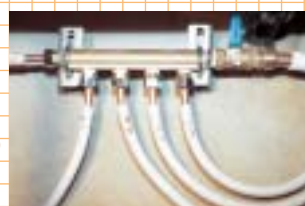
12 ヘッダーに接続完了(給湯)
