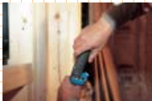
4 皮むき器で管端の被覆除去
