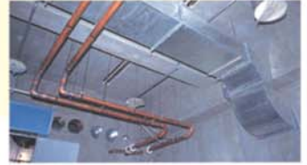
給水・給湯・冷水に使用される銅配管
