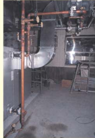
給水・給湯・冷水に使用される銅配管
