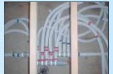
断熱材を巻いたヘッダー部
