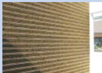
成城展示場のバルコニーには涼しく、防音性にすぐれた緑化タイルが採用されている
