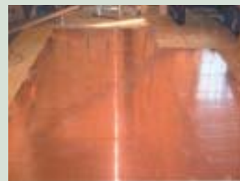
成城展示場の床暖房施工(温水式)
