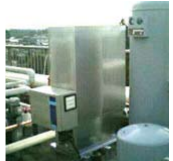
静岡県駿東郡 清水ホテル
