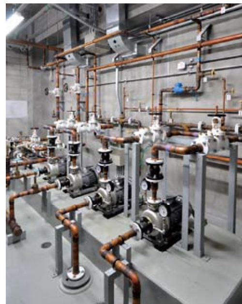
受水室の上水・中水・雨水槽、すべてに銅管が使われている
