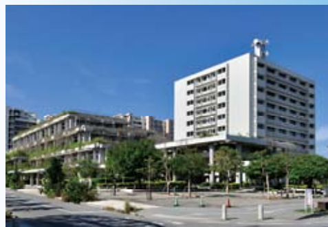
那覇第2地方合同庁舎(高い建物が2号館、奥が1号館)
