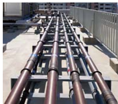
水は一旦屋上の高架水槽へ。そこから各階へと配水されていく
