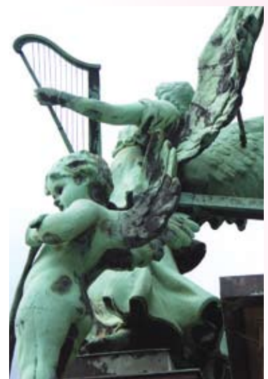
ベルリン大聖堂 銅葺きの天蓋の外回廊に設置されている銅像。(2005年撮影) ニューヨークの「自由の女神」と同様に打ち出し鍛金された銅板を内部の鉄の骨組みで支えている。緑青に覆われた銅像の黒変している部分は、ガルバニック腐食（鉄と銅の接触腐食）と思われる。 *同じくベルリンのブランデンブルク門につながる6月17日通り、ティーアガルテンの中央に立つ戦勝記念塔ジーゲスゾイレ（1864～1872）の頂きに立つ黄金の女神ヴィクトリア像（映画「ベルリン天使の詩」に出てきます）は、鑄造で金箔が張られている。
