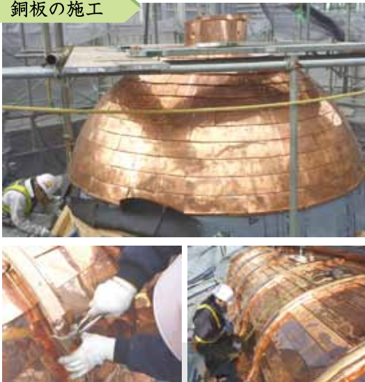
職人の手作業によって、銅板は施工された。
