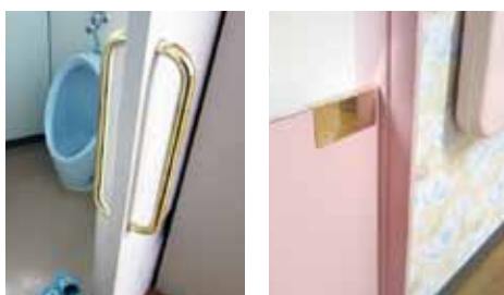
蛇口、トイレのドアノブ、キッチンのプッシュプレートなど子どもたちの手が触れる箇所に黄銅製品を導入
