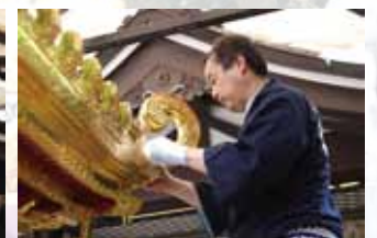
わらび手の取付け
