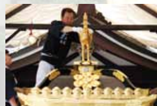
鳳凰の取付け
