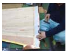
銅板を貼る前に防水処理を施す
