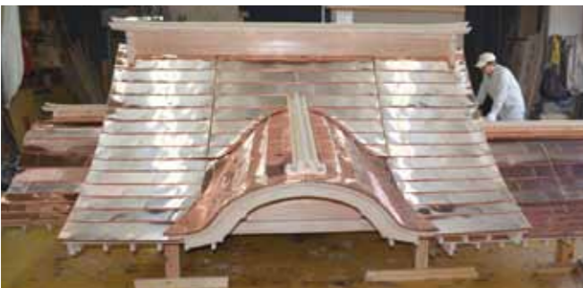
一文字葺きで葺かれた大船鉾の銅板屋根
