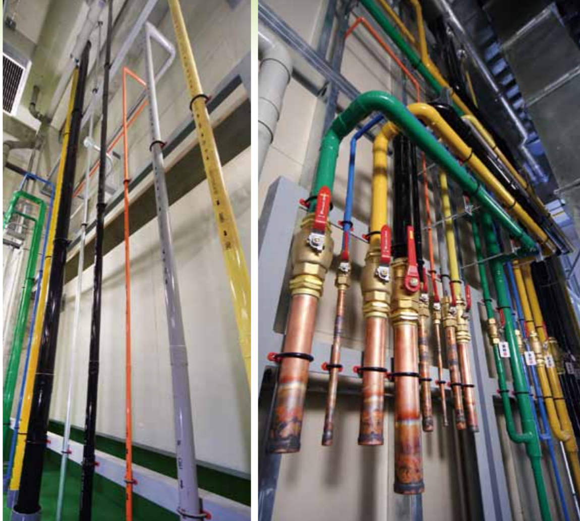
より地域医療に貢献できる新病院としてスタートした鹿児島市立病院。ここで採用されている医療ガス配管用銅管のサイズは、最大で100φ、一番細いものは10φ、最も多いのは20φ。すべて合わせると計4万mの銅管が使用されている。
