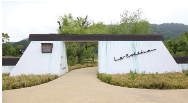
草葺き屋根のショップのドーマー、正門の屋根なども銅製。鮮やかな緑青も味わいの一つと、その経年変化を楽しんでいる
