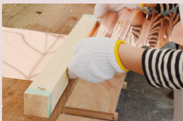
銅板を机と角材の間に挟み、上へ下へ。3〜4cm間隔で折り曲げる
