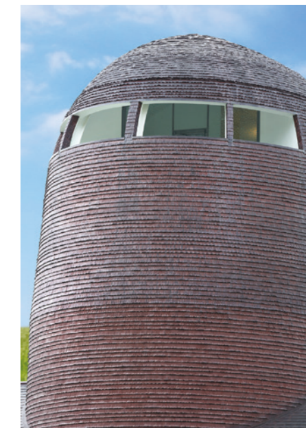
手折り加工した約5,400枚もの銅板を壁面・屋根に
