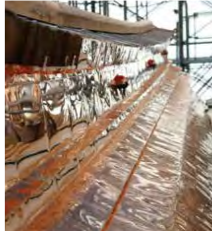
葺替えたばかりの箇所(右)に比べ、6か月前に作業を終えた銅板(左)は、すでに酸化皮膜が発生。味わいある落ち着いた風合いに変化している。
