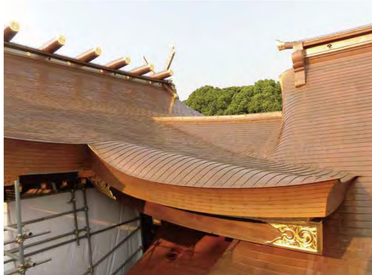
明治神宮では、鎮座百年祭記念事業の一環として各神門と廻廊、外拝殿、内拝殿、本殿などの銅屋根が葺替えられた。その施工屋根面積は9,979㎡。使用された四ツ切銅板はなんと約13万枚、その他役物を含めると銅板総使用量は約70トンにもなる。
