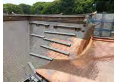
葺替えたばかりの箇所(右)に比べ、6か月前に作業を終えた銅板(左)は、すでに酸化皮膜が発生。味わいある落ち着いた風合いに変化している。
