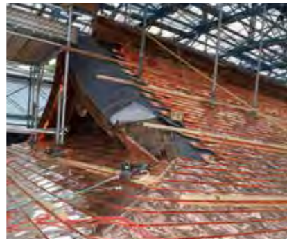
本殿屋根などの銅屋根は一字葺きである。熱による伸縮を綿密に計算し、雨漏り対策はもちろん美しい屋根の曲面も見事に再現した。
