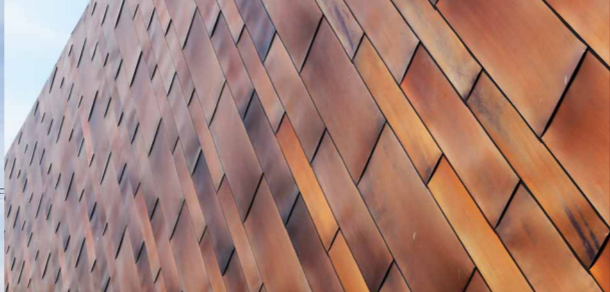
壁面は斜め葺きで施工されている。葺き板それぞれ手作業の硫化処理による色斑がグラデーションとなり、繊細な表情を生み出している。
