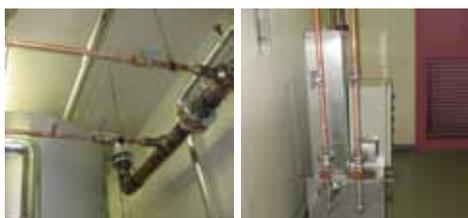
▲施工時の給湯用銅管 ▲脱気装置周りの配管
