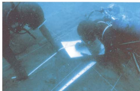
銅ネットの布設
