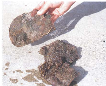
引上げられた銅ネット
