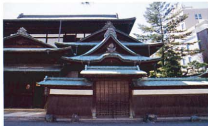
本館裏手の銅板屋根
