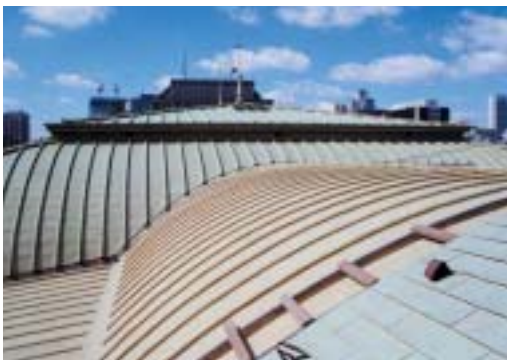
大屋根の修復
