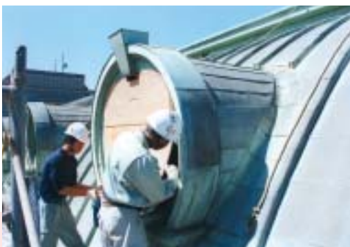
ドーマー窓部の調査
