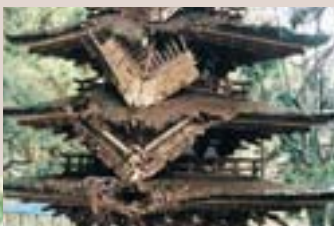
台風により塔の屋根は大被害
