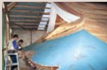
銅屋根への改修が進む鐘つき堂
