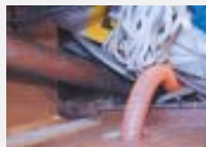
手前船壁にプロパンガス用銅配管が
