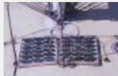
デッキに設置されたソーラーパネル
