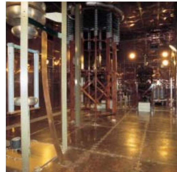
整合器室 ここでは送信機とアンテナの整合を図る。 床、天上、壁すべて銅でシールドされている
