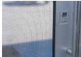
局舎全面に、銅メッシュが使用されている。もちろんガラス扉にもメッシュが入っている
