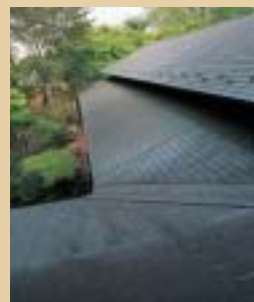
1階部分の銅屋根。小さく板どりをすることで波打ちを抑えている。
