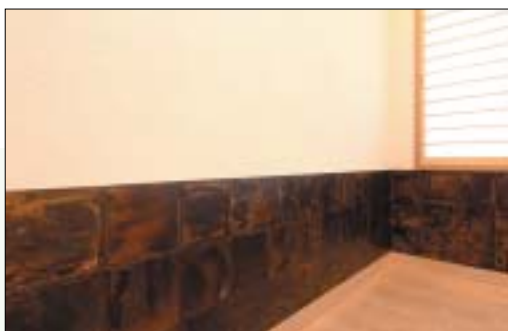
応接室の銅の腰壁
