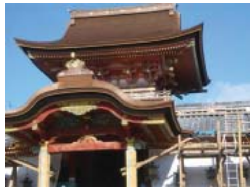
石清水八幡宮(写真は修造中)
