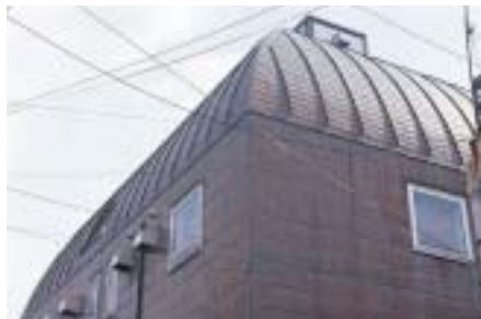
銅屋根・銅壁の様子
