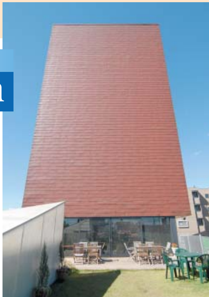
3階のカフェ屋上から見上げた銅の外壁
