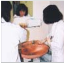
病室内の銅製洗面台
