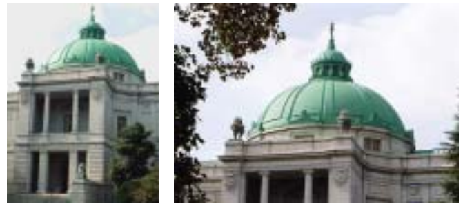
改修が完了したドーム屋根
