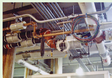
地下鉄駅舎の銅配管
