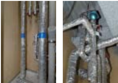
使用管種：建築配管用銅管(M) JWVA-H-101 使用場所：給湯設備(客室ユニットバス、客用洗面所、厨房) 使用量：4,910m、8,624.86kg
