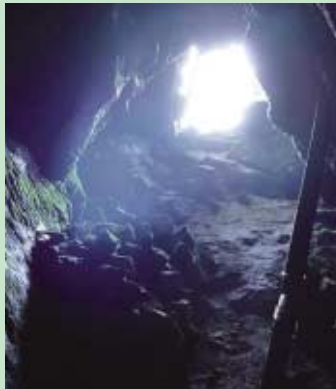
坑内より坑口を見上げる。坑内の天井高さは7~8mと高い
