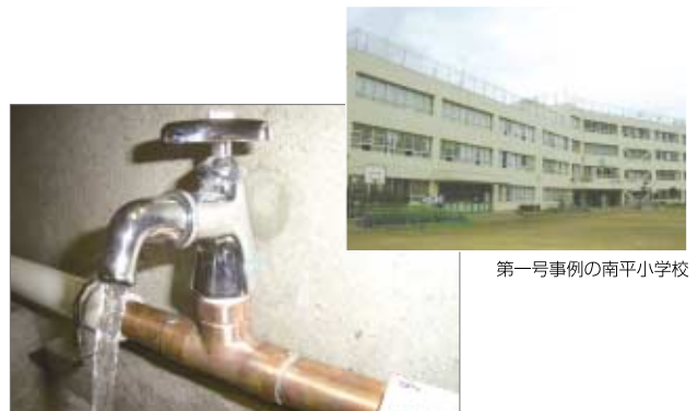
銅管に切り替えられた水道管
