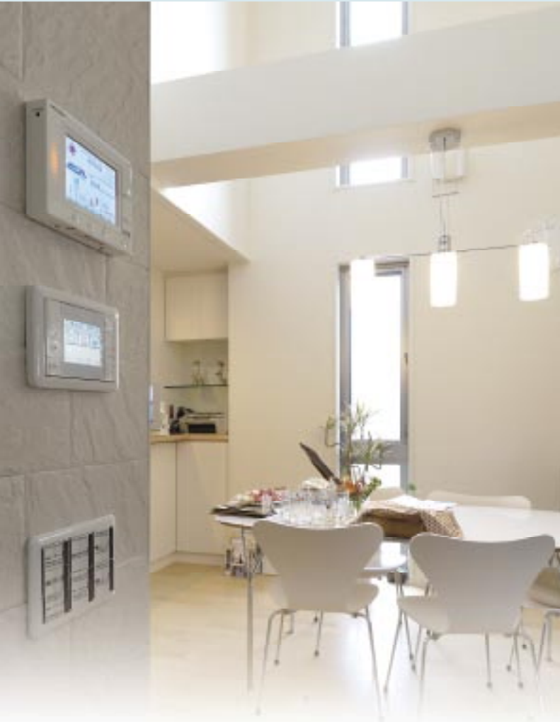
二階リビングには、オール電化された全設備を集中管理できるコントロールパネルがある
