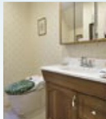
台所、バス、トイレなど、家中の給水・給湯配管に銅管を使用
