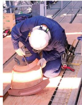
平瓦型銅板の最上部は絞り加工が施されており、職人が手作業で絞りをやっている。
