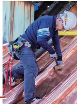
2枚の銅板の端を折り曲げ、引っ掛け合わせて継ぐ「はぜ組」で繋ぎ合わせている。はぜ部分を木槌で叩いて組み合わせる。
